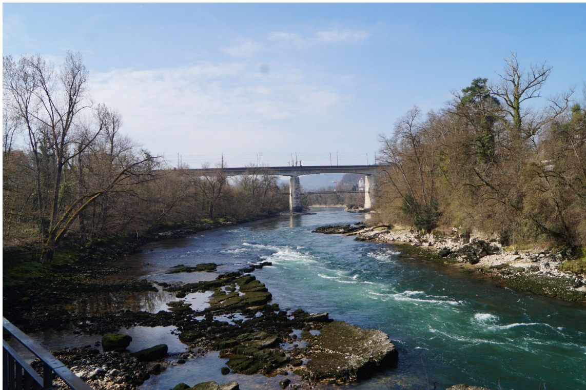
Die Aare mit der neuen Eisenbahnbrücke aus Beton
